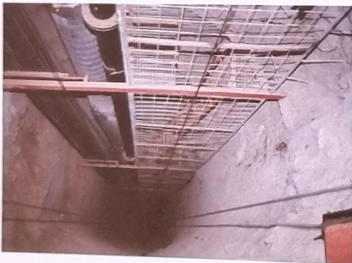
Foto inferior derecha: Tramo inicial de la galería de fondo del pozo. Se puede apreciar la tubería de aireación y, debajo de ella, la de conducción y elevación de agua.
